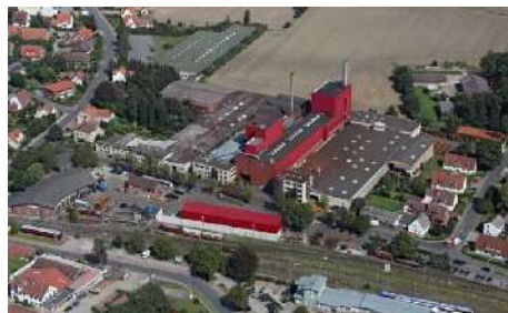
Heinrich Meier Eisengießerei GmbH & Co. KG Rahden Gießerei
